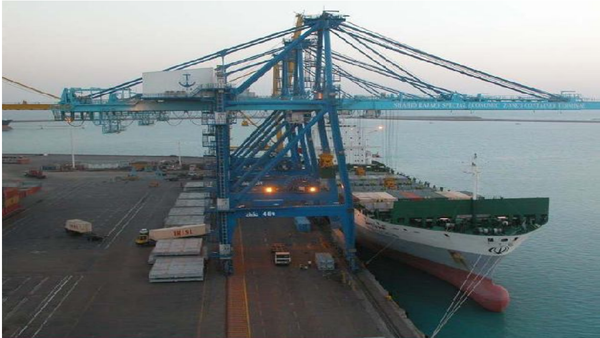
شکل 3-5- نمای از اسکله جهت پهلوگیری کشتی‌ها در بندر شهید رجائی
