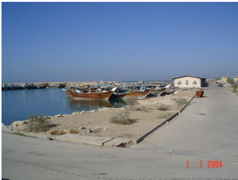
تصویر ۴. نمای شمال شرقی به جنوب غربی در بندر نخل تقی
